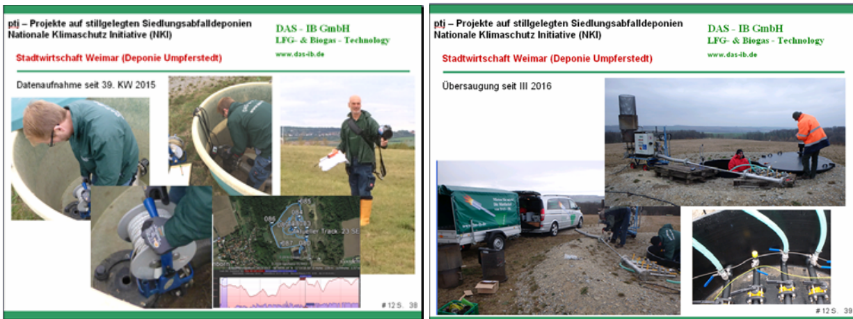
Abb. 10 – Bestandsaufnahme des Gasfassungssystem (li) und rechts IBN der Versuchsanlage auf der Deponie Umpferstedt
